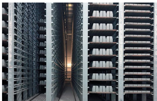
Камера набора прочности (твердения) на 7000 м 2
